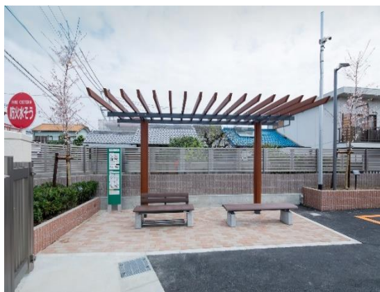
地域交流スペース (防災用かまどベンチ)
